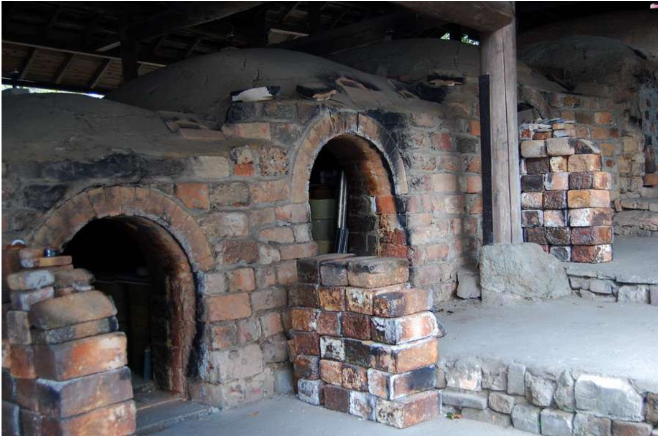
Рис. 19. Печь ноборигама («взбирающаяся печь»): Вверху: вертикальный разрез. Внизу: ноборигама с купольными камерами, мастерские Тин Дзюкан, Кагосима (современный вид).
