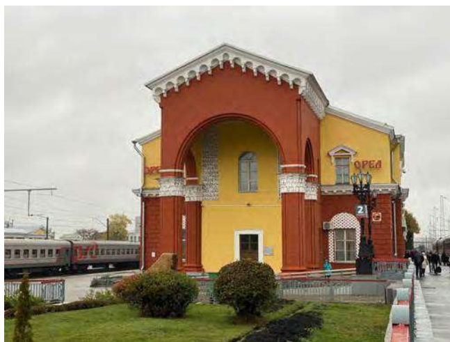
Илл. 189. Вокзал в Орле. Боковой фасад главного корпуса с северной стороны. Фотография автора. 2019.
