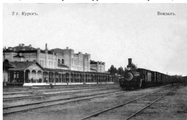
Илл. 131. Вокзал на узловой станции Курск. Вид со стороны путей. Почтовая открытка. До 1912.
