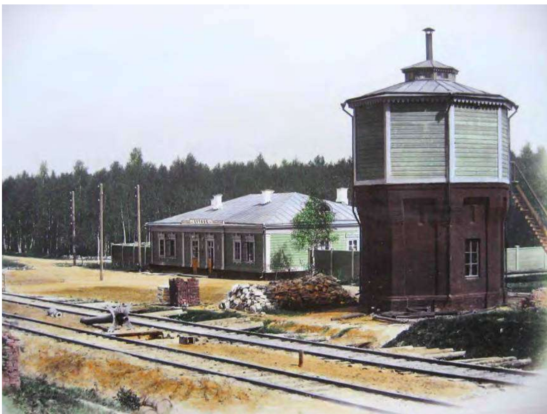
Илл. 45. Полустанция Бутово. Общий вид.
