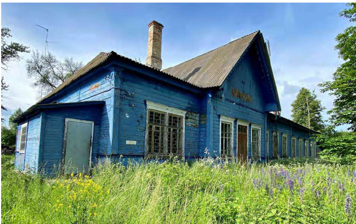
Илл. 235. Остановочный пункт Думчино. Деревянное пассажирское здание по типовому проекту 1869-1870 гг. для 3, 4 и 5 отделений дороги. Фотография автора. 2021.
