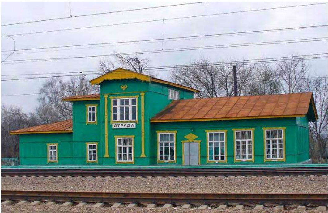
Илл. 237. Станция Отрада. Деревянное пассажирское здание по типовому проекту вокзалов III и IV классов 1866 г. Вид со стороны путей. Фотография А. Киреева. 2010. Источник изображения: http://orel-story.ru/forum/shared_files/storage/Kireev/pvaksqtofzynnjlzfat.jpg
