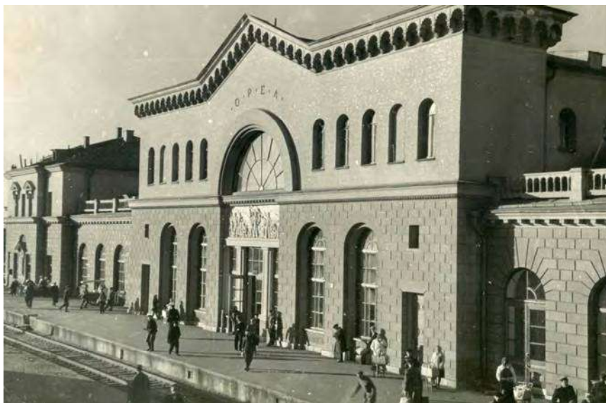
Илл. 188. Вокзал в Орле. Фасад главного корпуса, противоположный площади. Фотография неизвестного автора. 1950-е.
