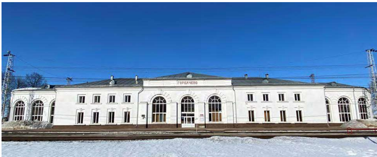
Илл. 212. Вокзал островного типа на станции Горбачево. Фотография автора. 2021.
