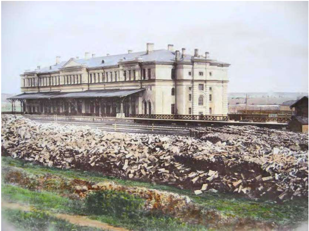
Илл. 25. Пассажирское здание станции I класса Тула. Вид со стороны путей. Арх. М.Г. Арнольд. Источник изображения: Альбом видов Московско-Курской железной дороги. М., [1885].
