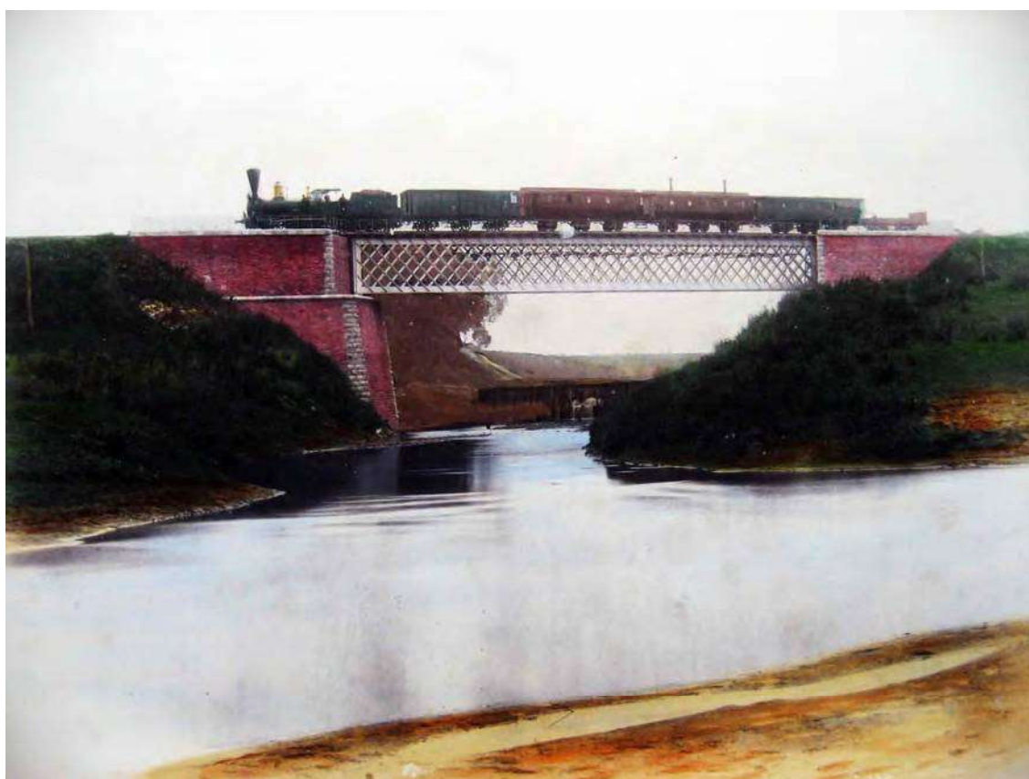
Илл. 78. Мост через реку Оптуху.
