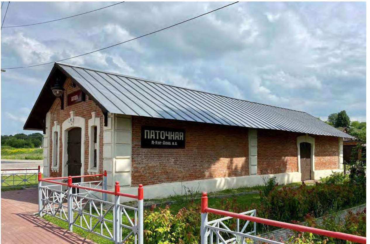
Илл. 144. Станция Плавск (Сергиево, Паточная). Здание багажного отделения. Фотография автора. 2021.
