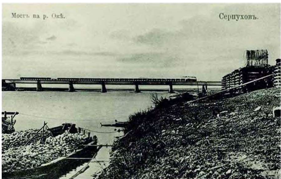
Илл. 69. Мост через реку Оку в г. Серпухове. Почтовая открытка. 1900-е.
