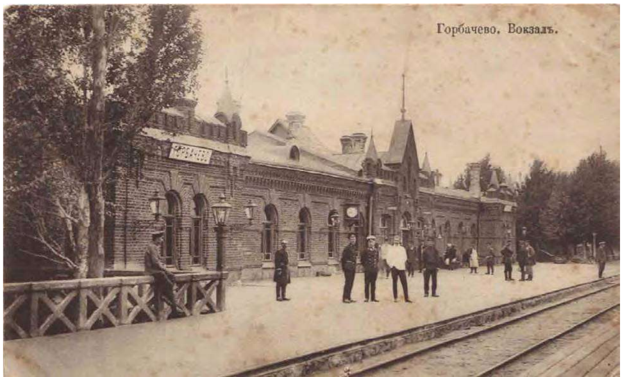
Илл. 146. Вокзал на станции Горбачево. Вид со стороны путей. Почтовая открытка. 1916.
