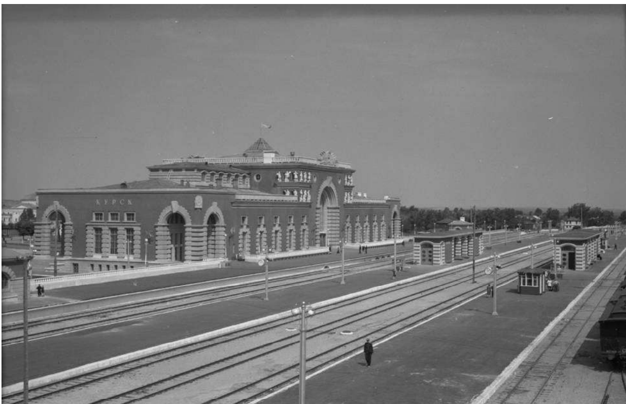
Илл. 203. Вокзал в Курске. Общий вид со стороны пассажирских платформ. 1952. Фотография неизвестного автора. Источник изображения: Музей архитектуры им. А.В. Щусева.
