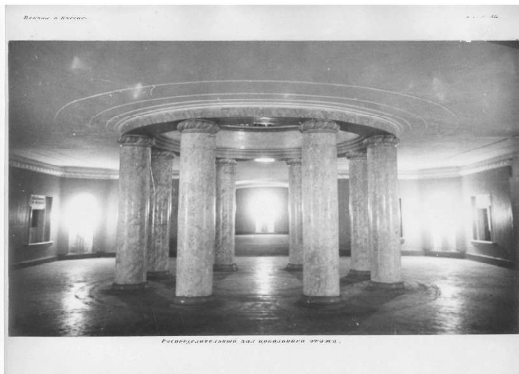
Илл. 200. Вокзал в Курске. Распределительный зал цокольного этажа. Фотография неизвестного автора. 1952. Источник изображения: Музей архитектуры им. А.В. Щусева.
