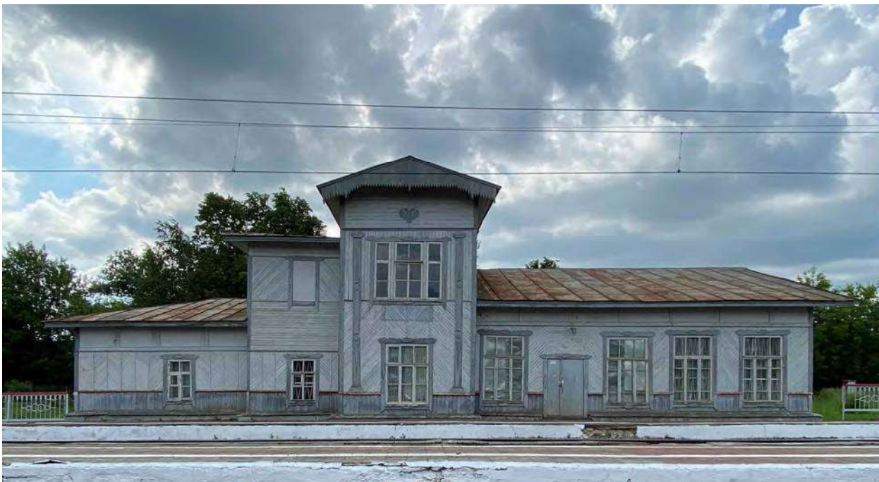
Илл. 238. Станция Отрада. Деревянное пассажирское здание по типовому проекту вокзалов III и IV классов 1866 г. Вид со стороны путей. Фотография автора. 2021.
