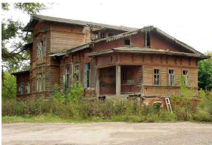
Илл. 100. Здание товарной конторы на станции Сергиево II-е. Фотография. 2000-е. Источник изображения: http://www.kukushka.ru/rasskaz/13.html
