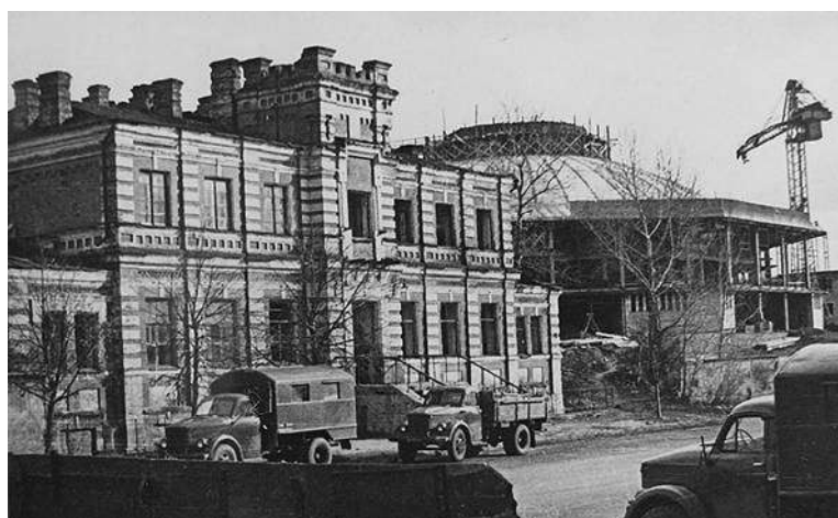
Илл. 112. Курск. Строительство цирка. Фотография. 1968-1969. Источник изображения: https://pastvu.com/_p/d/y/3/k/y3kxvoytut4o4je0il.jpg
