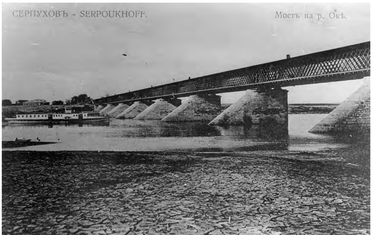
Илл. 68. Мост через реку Оку в г. Серпухове. Почтовая открытка. 1900-е.
