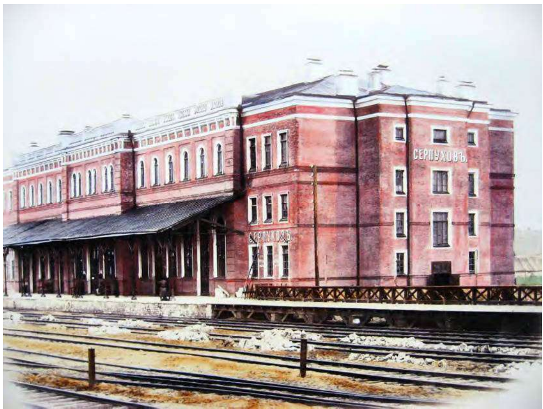
Илл. 28. Пассажирское здание станции II класса Серпухов. Вид со стороны путей. Арх. М.Г. Арнольд. Источник изображения: Альбом видов Московско-Курской железной дороги. М., [1885].
