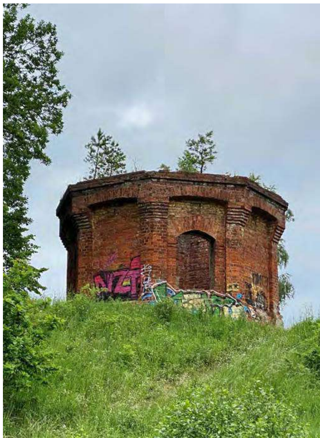
Илл. 232. Платформа Приокская (до 1964 – полустанция Свинская). Фрагмент водоемного здания по типовому проекту 1864 г. Фотография автора. 2021.
