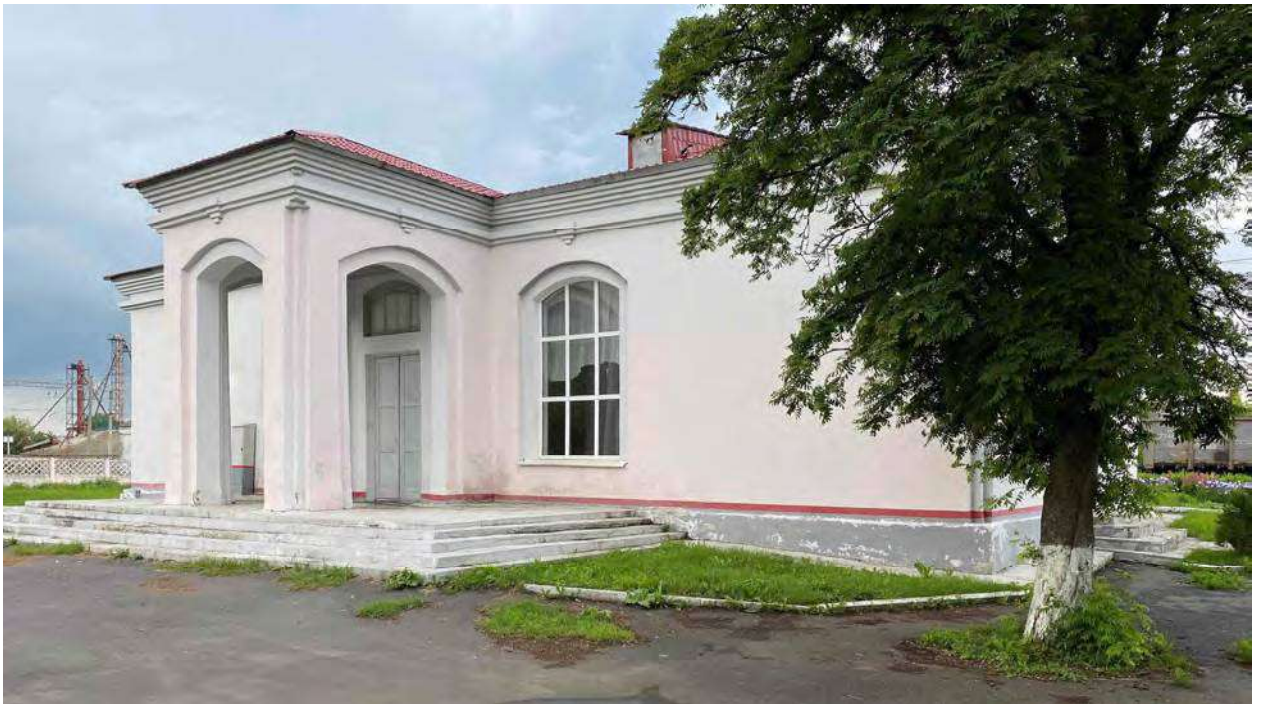
Илл. 209. Вокзал на 50 человек на станции Становой Колодезь. Вид со стороны площади. Фотография автора. 2021.
