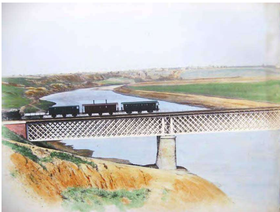
Илл. 76. Мост через реку Пахру.
