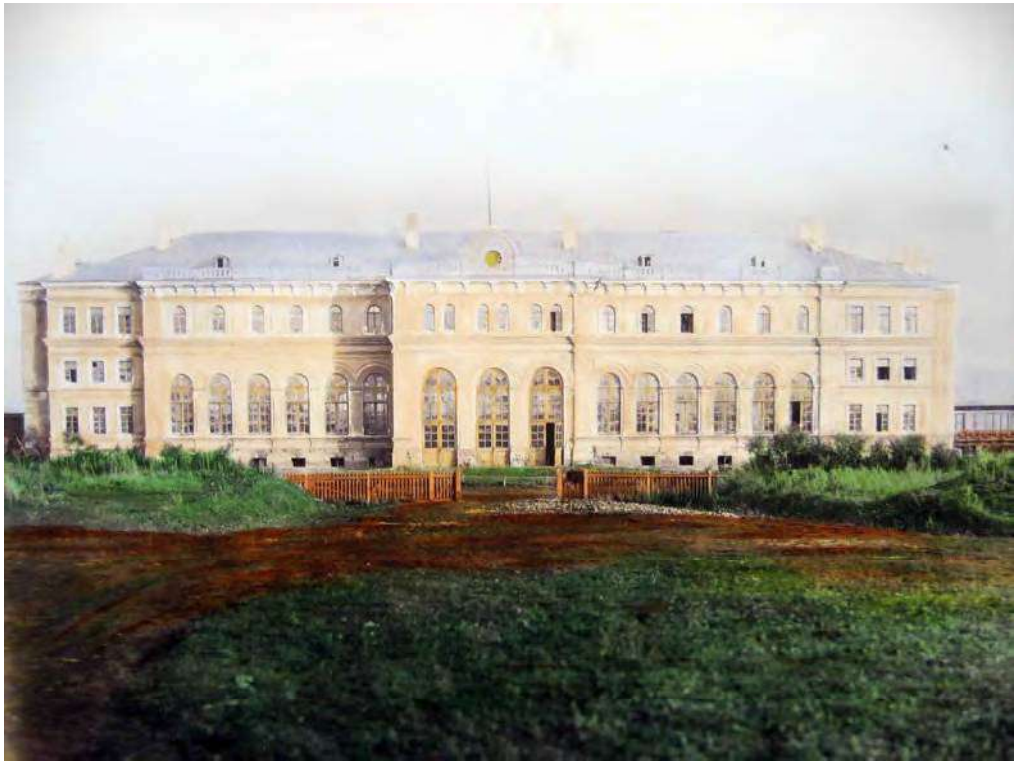
Илл. 27. Пассажирское здание станции II класса Скуратово. Вид со стороны площади. Арх. М.Г. Арнольд. Источник изображения: Альбом видов Московско-Курской железной дороги. М., [1885].
